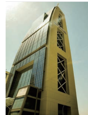
Saudi Arabia AL Munajem Office Tower
